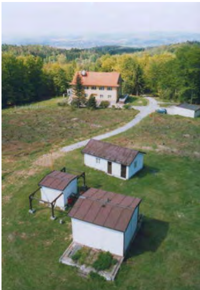
Obr. 8 – Observační plošina na GO Pecný, v pozadí hlavní budova observatoře
