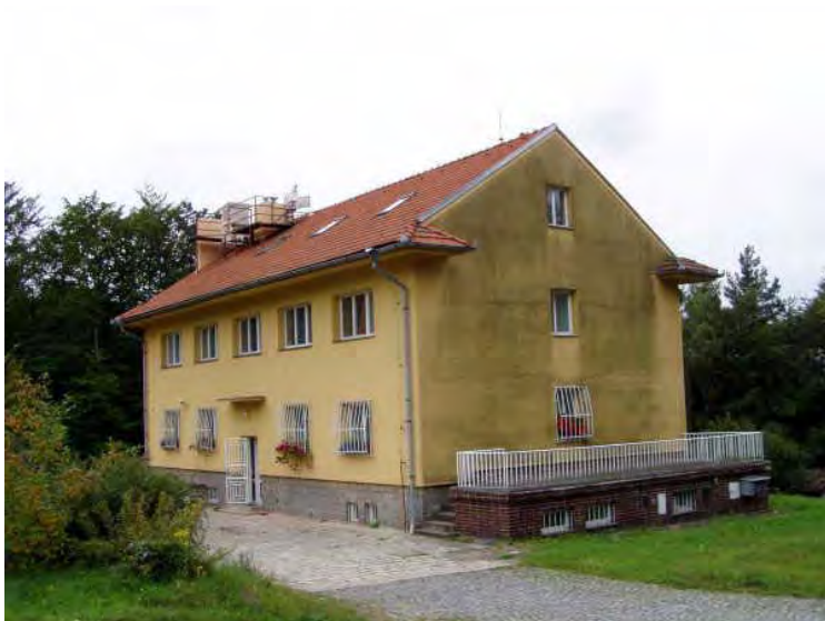
Obr. 12 – Hlavní budova observatoře na GO Pecný, v pozadí observační pilíře technologie GNSS
