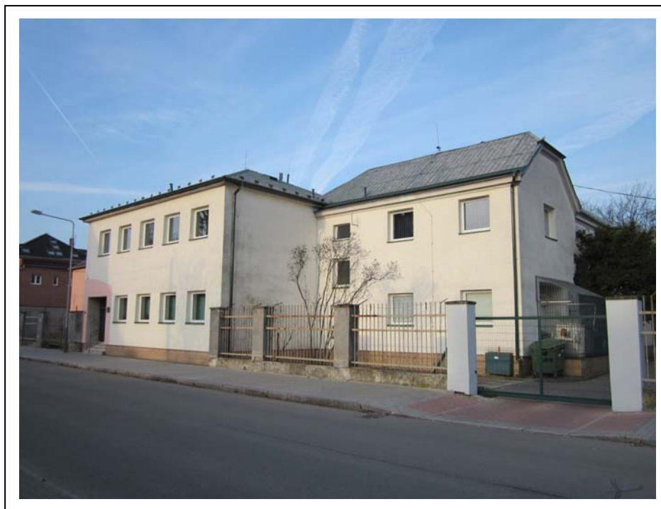
Objekt RC SÚJB Ostrava
