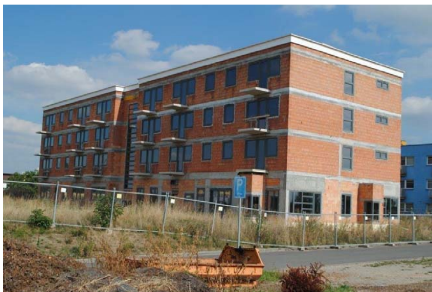
Rozestavěná ubytovna v Krči
