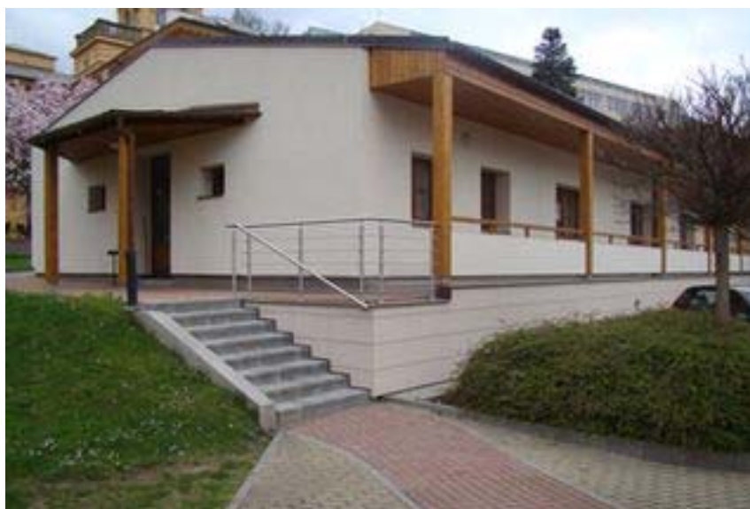
Zateplení budovy A vily Lanna
