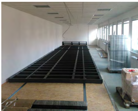
Obr. 5 : Instalace posuvných regálů
