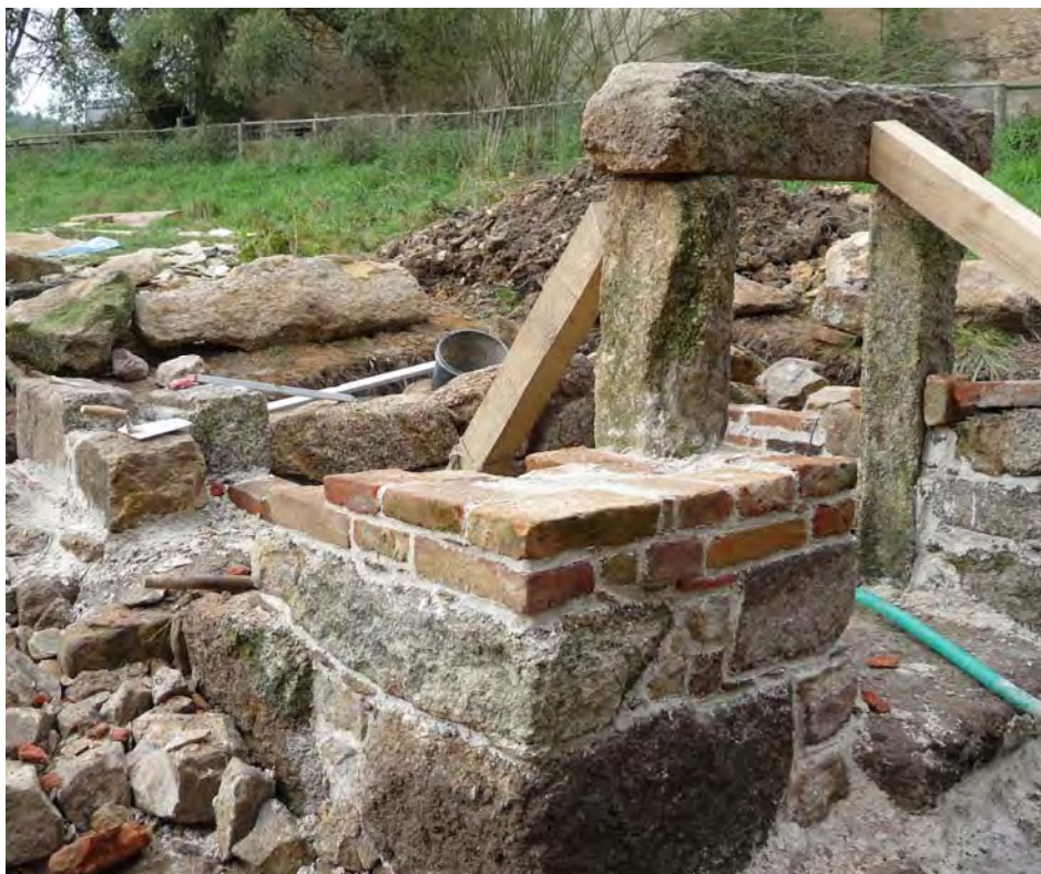
Rekonstrukce haltýře v obci Salajna, Česká republika
