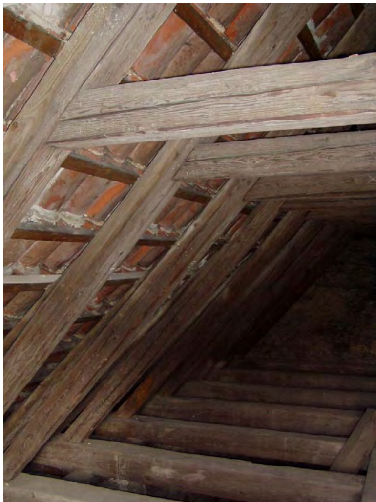
Krovová konstrukce barokního kostela
