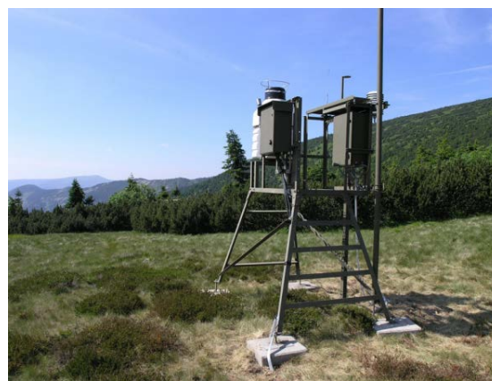
Obr. 7 Monitorovací stanice s dálkovým přenosem dat na Výrovce (Krkonoše).
