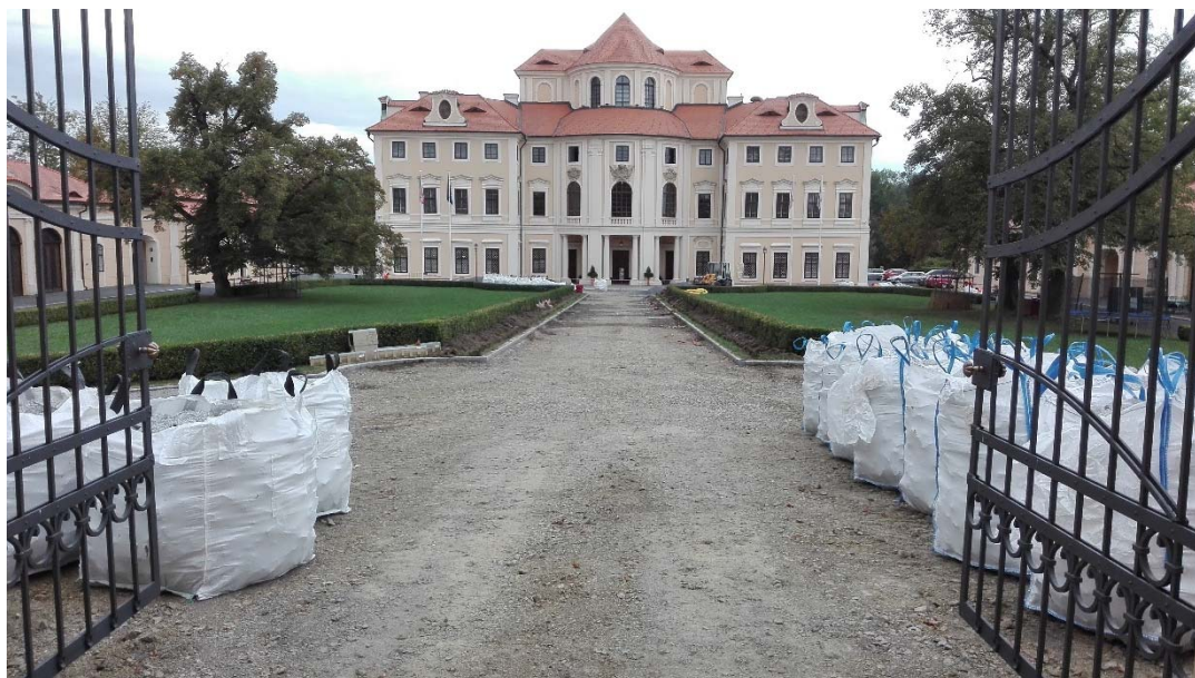
Oprava příjezdové cesty v KCL
