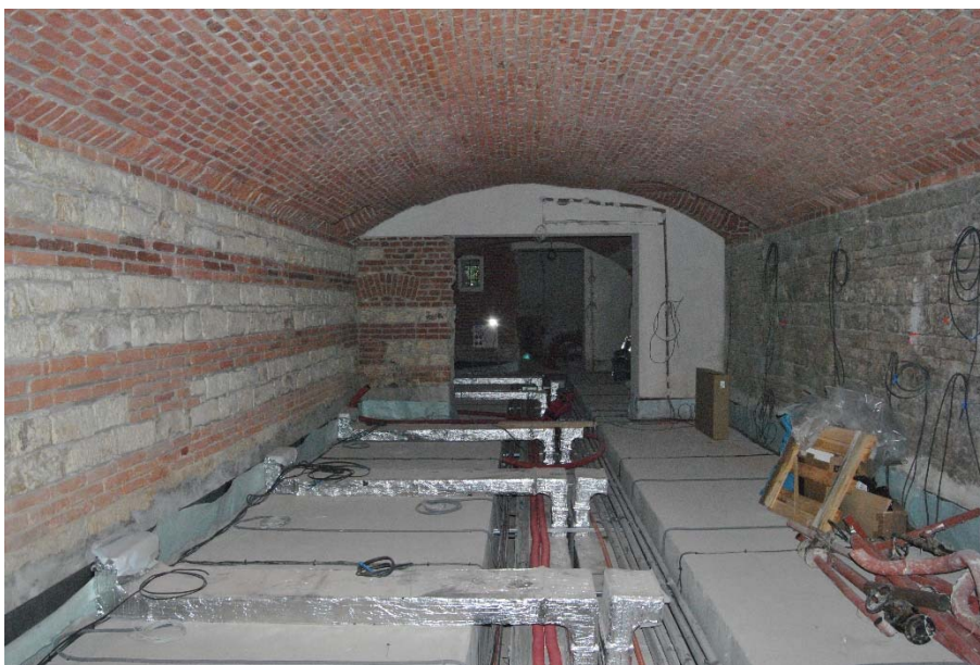
Oprava jednacího sálu VL
