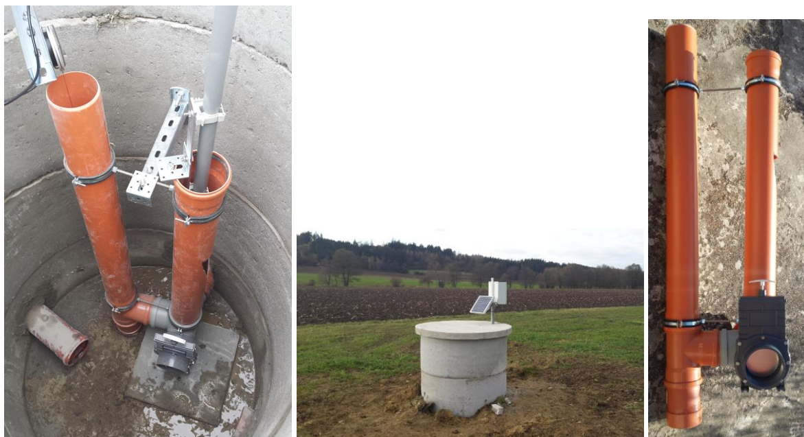
Obr. 17: Lokalita Helvíkovice s upravenou tradiční stavbou odvodnění. Provedení R.P. a instalace nové regulační šachtice obnovou/opravou šachtice původní.
