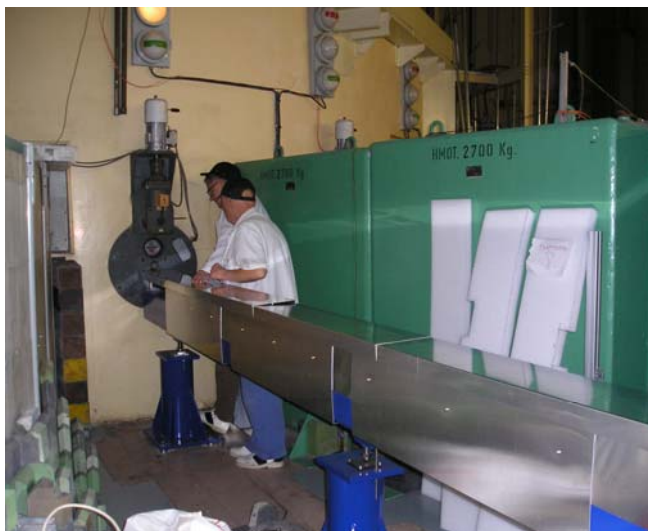
Obr. 4. Instalace nového zrcadlového neutronovodu na horizontálním kanálu HK-3 výzkumného reaktoru LVR-15.
