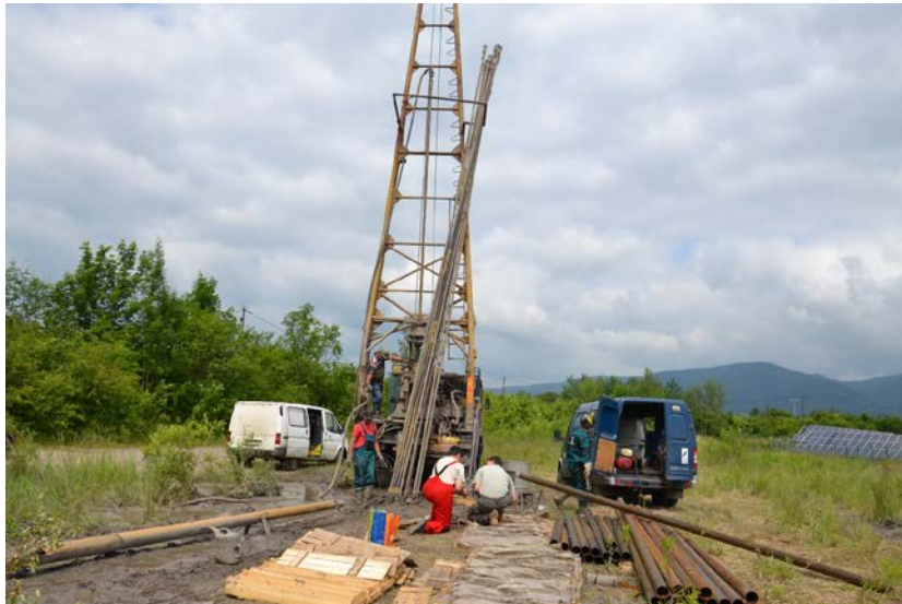
Vrtné práce. Studované usazené horniny byly odebírány z hloubek dosahujících 300 m díky projektu VODAMIN.
