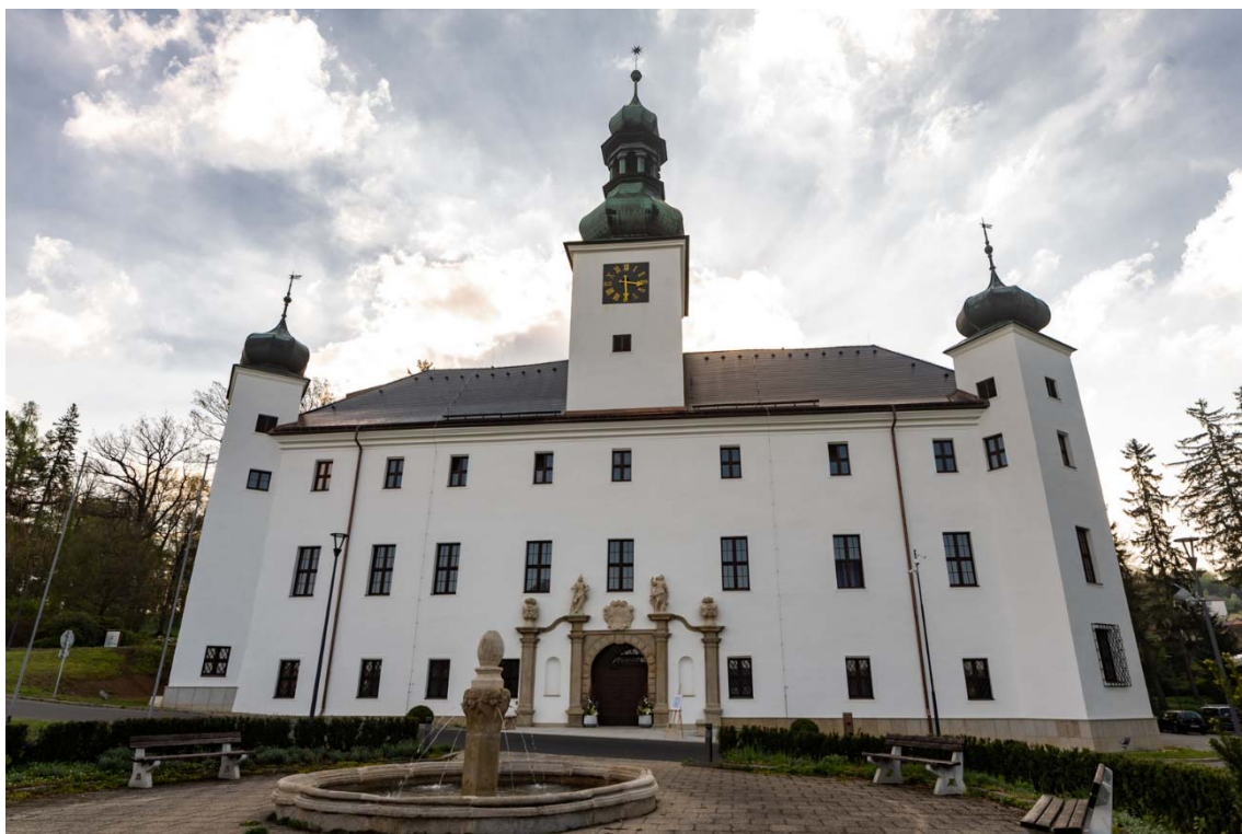
Zrekonstruovaný zámecký hotel Třešť
