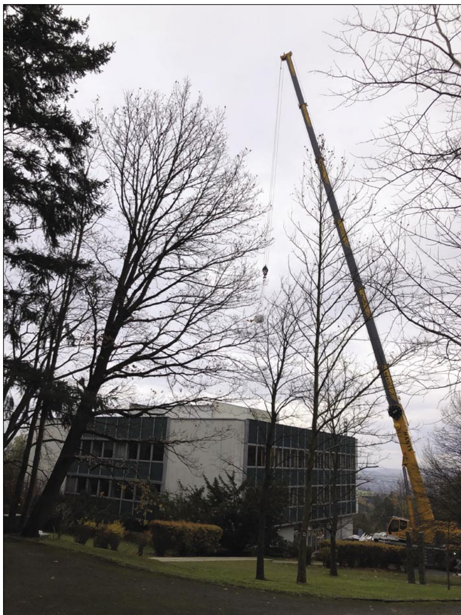
Technicky náročná oprava střechy Kosmické laboratoře proběhla na podzim r. 2021.
