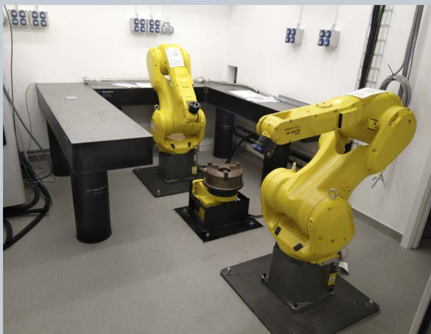
Obr. 2.5.2 Pracovní prostor nové LSP stanice těsně po instalaci robotů.
