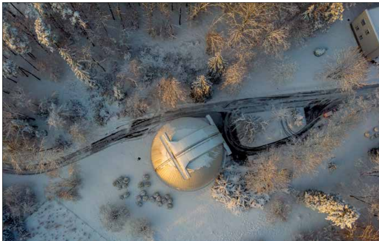
Kopule Perkova dalekohledu
