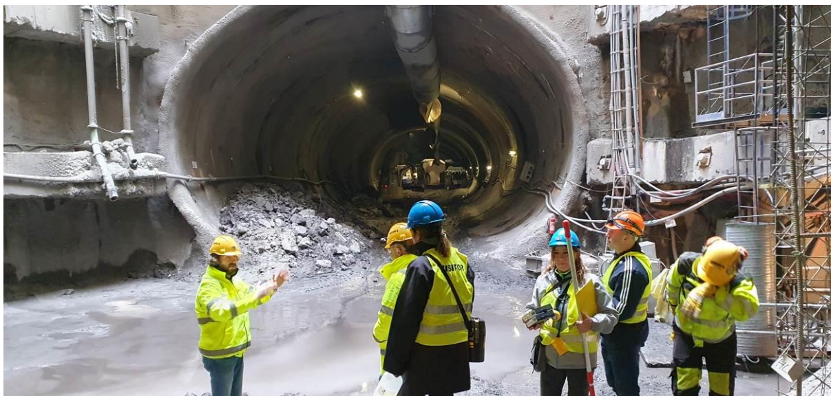
Výstavba metra, trasa D – budoucí stanice Olbrachtova
