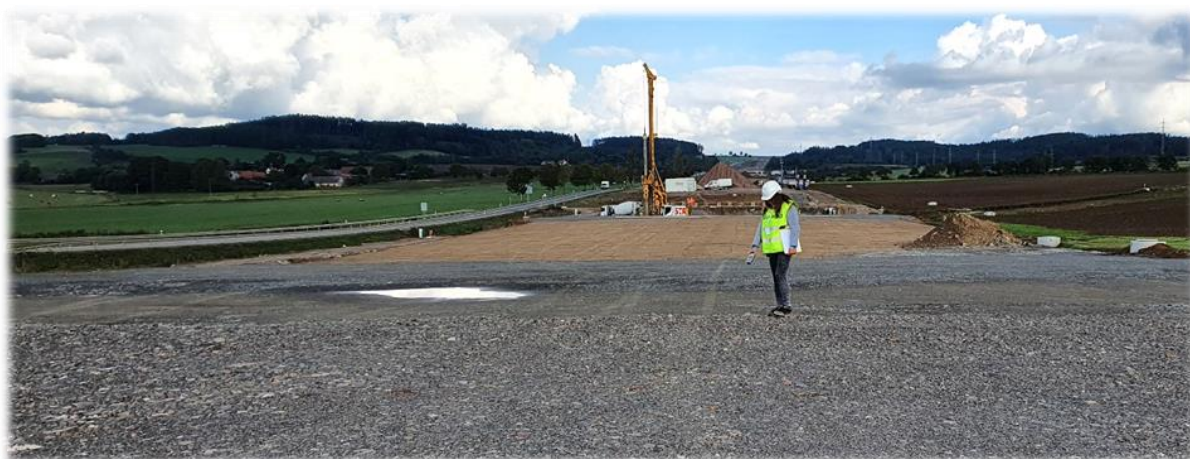
Měření místa návozu kameniva při výstavbě dálnice D4 v úseku Háje – Zalužany
