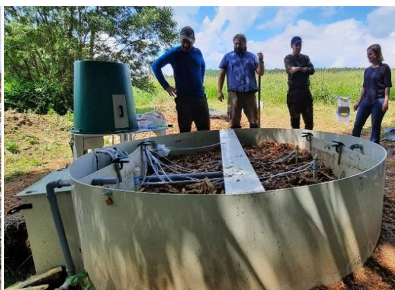
Obr. 5 Plnění biofiltru štěpkou (foto: J. Konečná)
