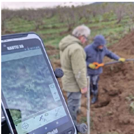
Obr. 2 dohledání drénu a jeho odkrytí (foto: P. Fučík)
