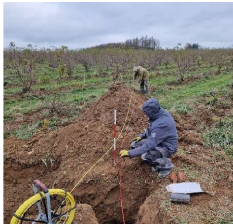
Obr. 3 inspekce drenáže (foto: P. Fučík)
