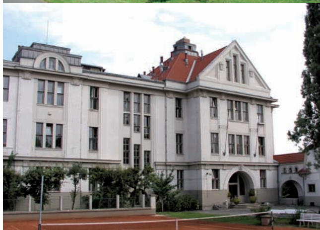
FZÚ AV ČR – pracoviště Cukrovarnická 10 v Praze 6
