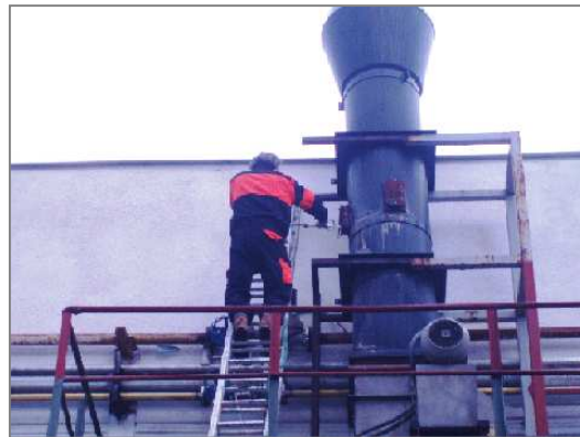
Odběr vzorků z výduchu sušárny uranového koncentráту v o.z TÚU, s. p. DIAMO Stráž p.R.
