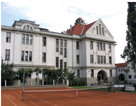
FZÚ AV ČR – pracoviště Cukrovarnická 10 v Praze 6
