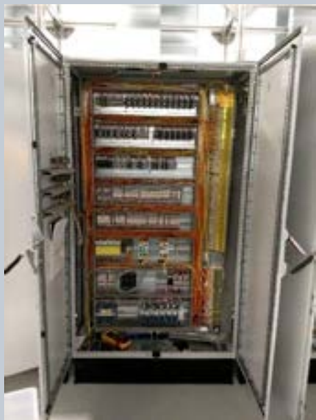
Obr. 2.6.29: Rozvaděč interlockového systému v hale L2
