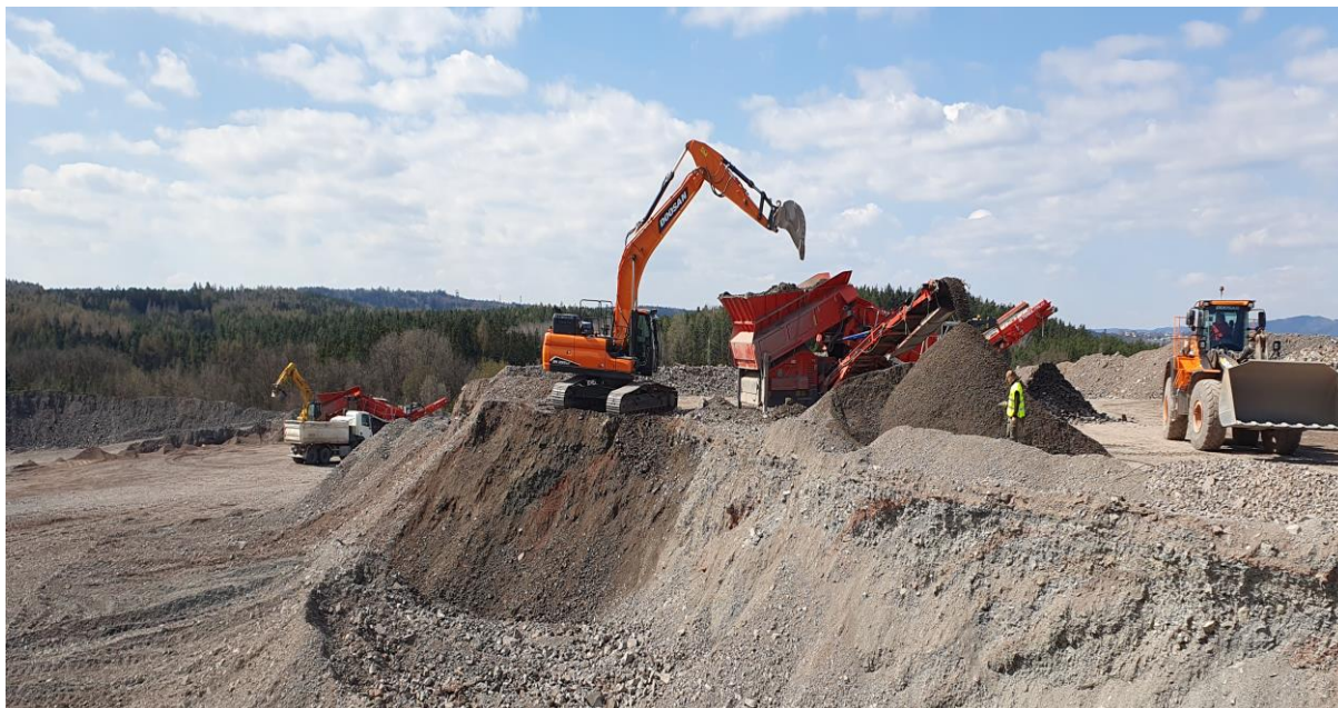
Kontrolní měření při výstavbě dálnice D4 v úseku Háje – Zalužany
