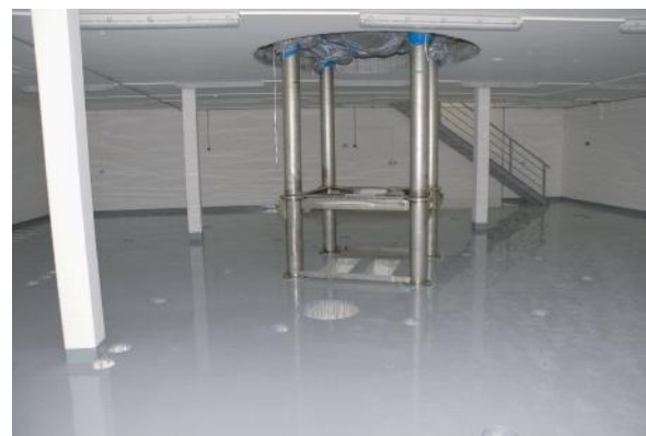
Obr. 4: Hala tokamaku – přízemí.
