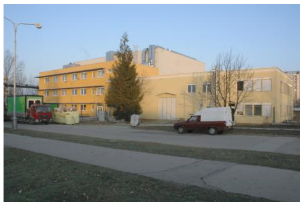
Obr. 1: Budova tokamaku - jižní pohled.
