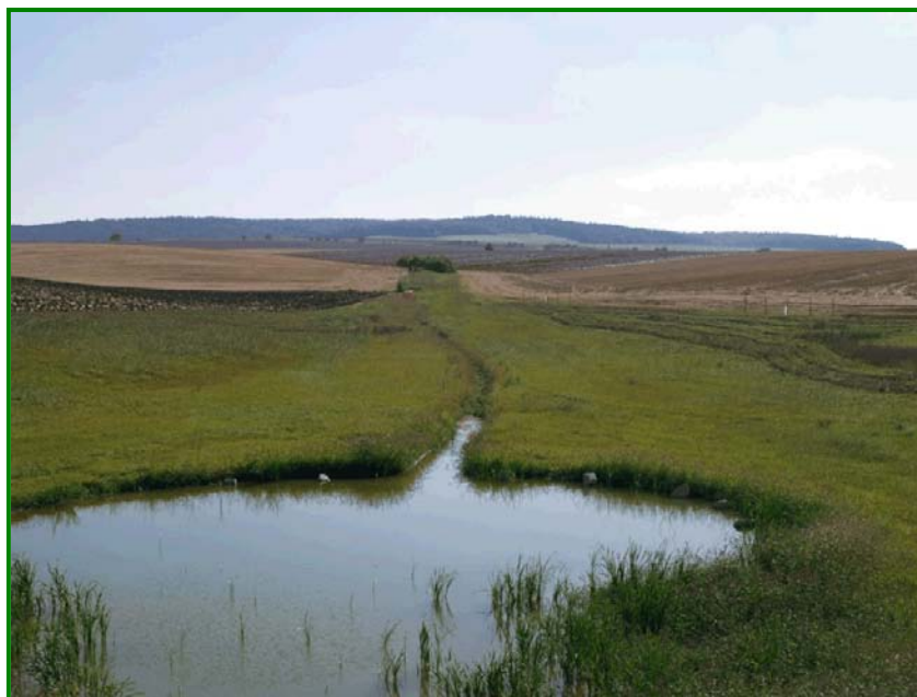
Obr. 9 Technické protierozní opatření (pohled na zatravněnou údolnici z koruny hráze suché nádrže)
