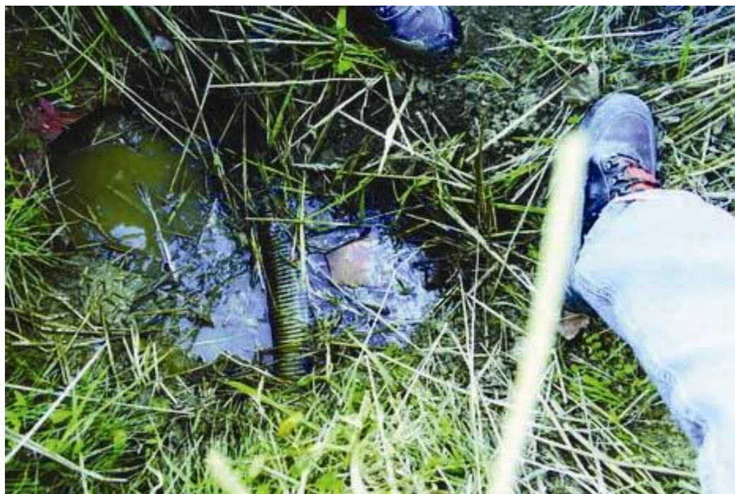
Obr. 3: Rozplavování a vnitřní eroze půdy způsobená neudržovaným drenážním systémem a vytváření zatopených podzemních kaveren (okres Přerov)
