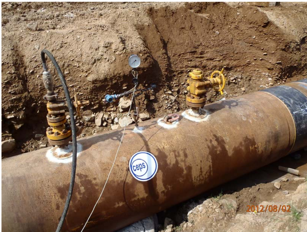
Tlakování plynovodního potrubí v rámci rehabilitace
