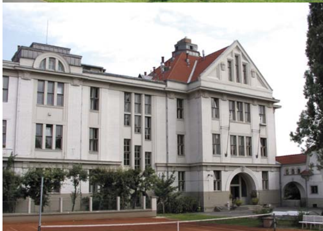
FZÚ AV ČR – pracoviště Cukrovarnická 10 v Praze 6
