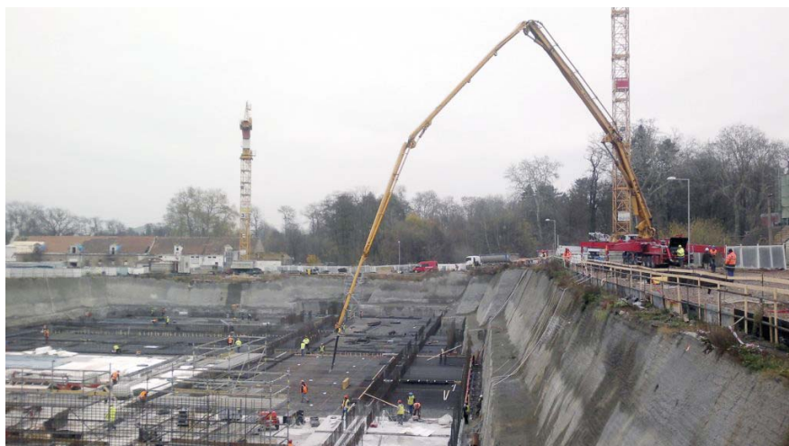
■ Obr. 3 Stavba laserového centra ELI-Beamlines v Dolních Břežanech – betonáž základové desky laserové haly (listopad 2013).
