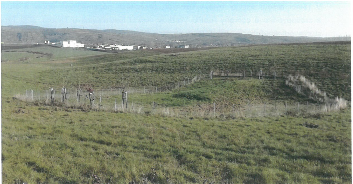
Obr. č. 15: Zatrávněná údolnice s přehrážkou v povodí Stanovice - Hustopeče
