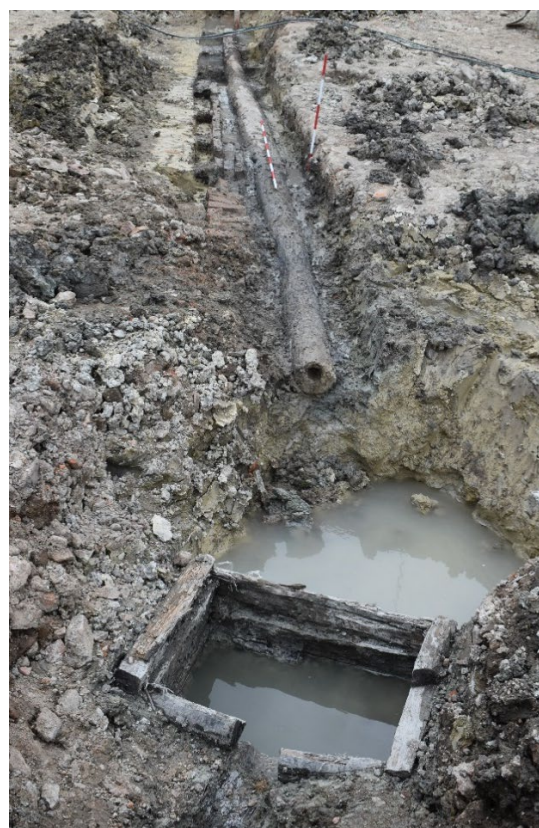
Tišnov – cihlové a kamenné kanalizační stoky a dřevěný vodovod z novověku
